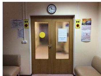
устанавливать в помещениях и зонах общественных зданий и сооружений, посещаемых МГН, и производственных помещениях, имеющих рабочие места для инвалидов. В дошкольных образовательных организациях данные оповещатели и знаки следует устанавливать только на путях эвакуации.
